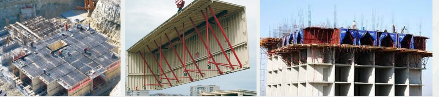
Şekil 4.3. Tünel kalıp sistem ile bina inşaatı
