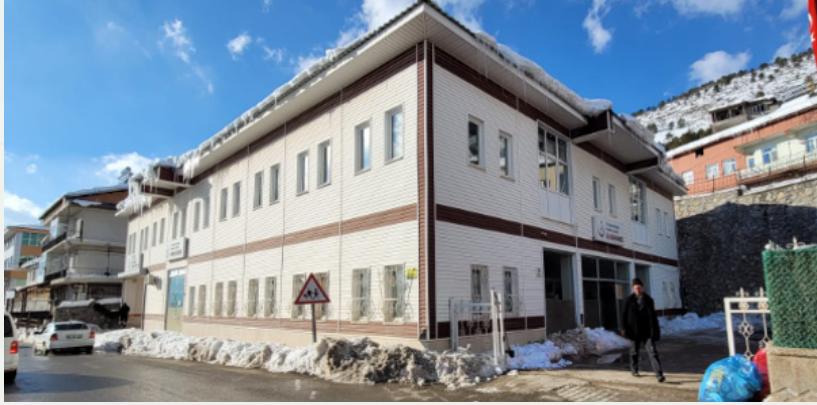
Şekil 3.65. Çelikhan İlçesi ASM binası
