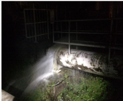
Şekil 5.2.4. Kumamoto Depremi sırasında 800 mm çaplı bir borunun birleşim noktasında meydana gelen sızıntı (Wham ve diğ., 2017)
