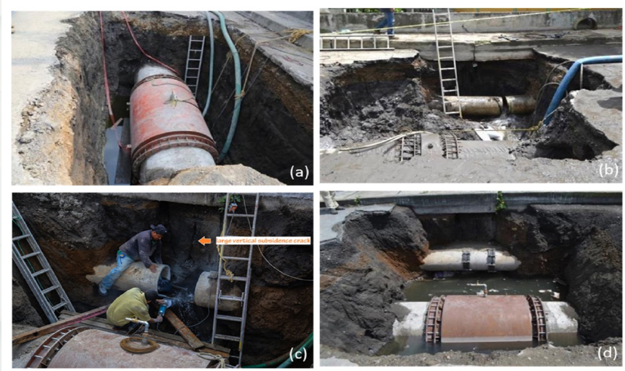
Şekil 5.2.5. Mexico City’deki Colonia Del Mar bölgesinde yaygın olarak görülen boru hattı hasarları ve onarımı (Lemnitzer ve diğ., 2021)
