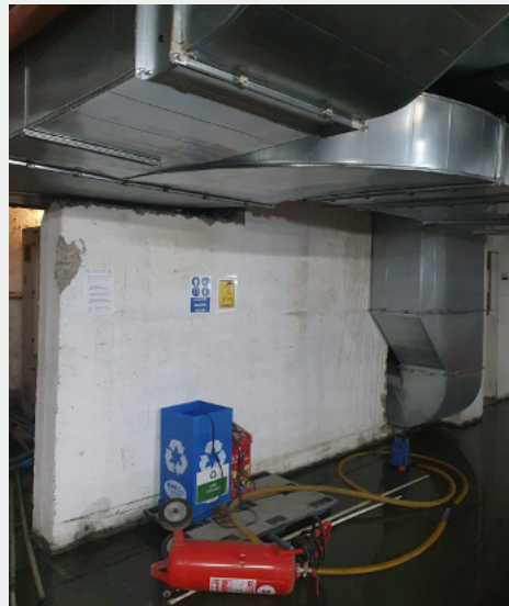
Şekil 3.47. Adıyaman Özel Gözde Tıp Merkezi kesilen betonarme perde duvar
