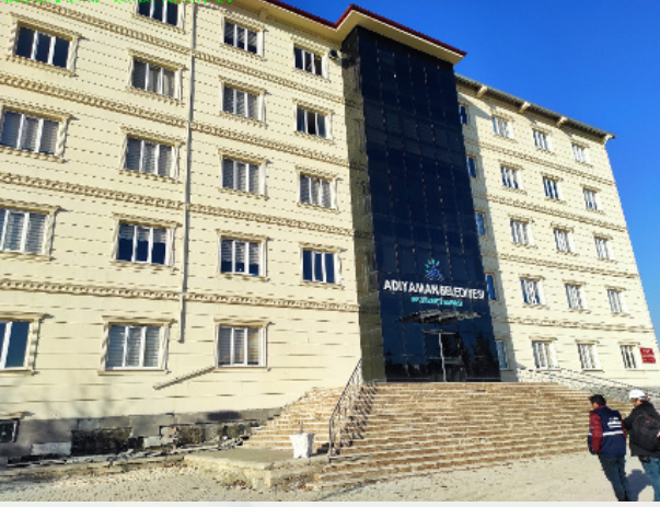
Şekil 3.54. Ek Bina ve zeminde oturma, merdiven hasarı
