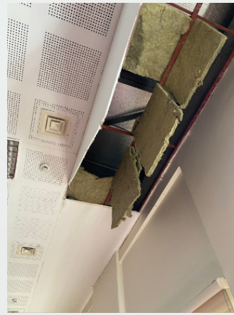
Şekil 3.50. Asma tavan ve bölme duvar hasarları
