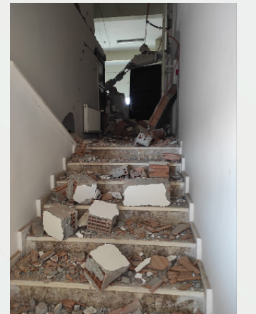
Şekil 3.50. Asma tavan ve bölme duvar hasarları
