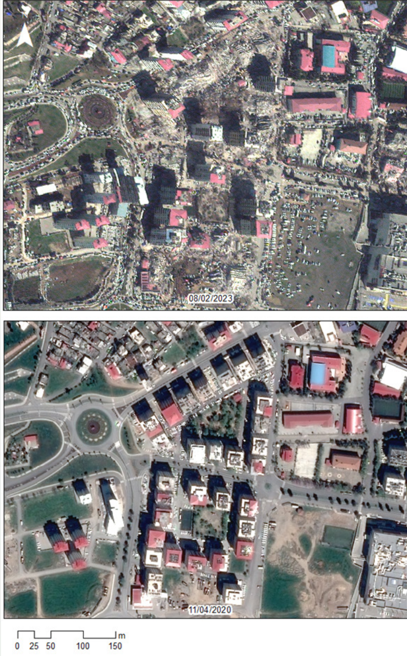
Şekil 3.7. Kahramanmaraş merkez deprem öncesi ve sonrası uydu görüntüleri
