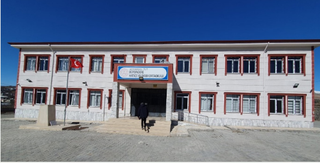
Şekil 3.67. Boyundere Hatice Yıldırım Ortaokul binası
