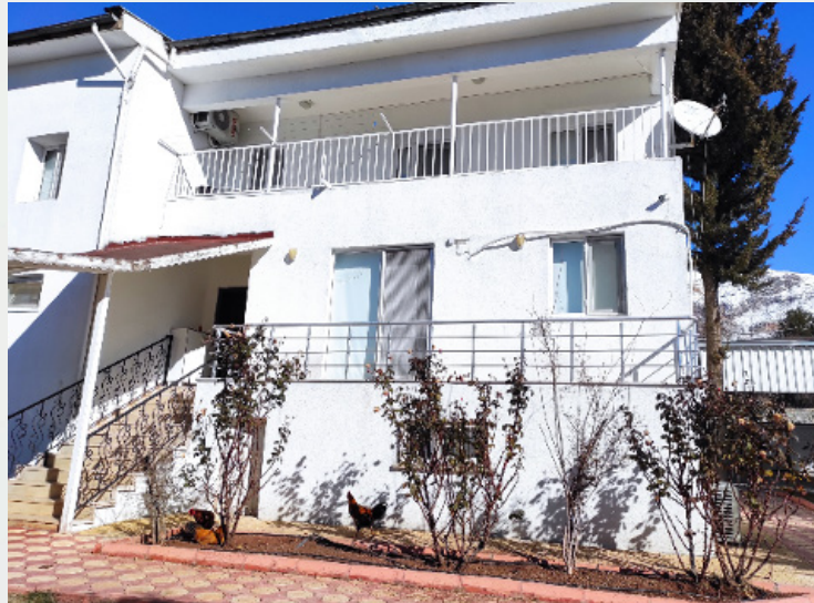
Şekil 4.60. Kaymakamlık Lojmanı binasının genel görünüşü
