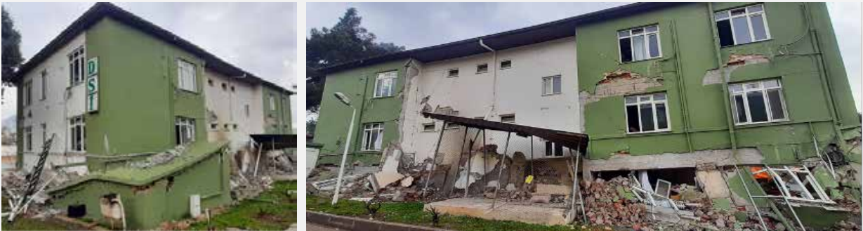
Şekil 21. Devlet Su İşleri Binası, Antakya
