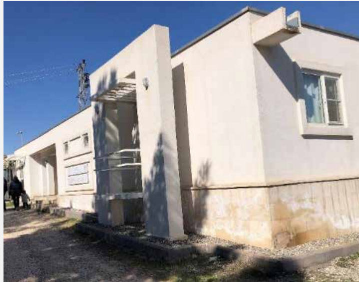
Şekil 3.75. İncelenen çelik yapılardan görünüm
