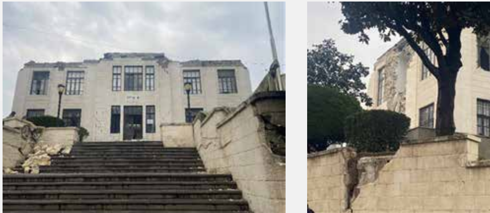
Şekil 17. Hatay Büyükşehir Belediyesi Ek Hizmet Binası
