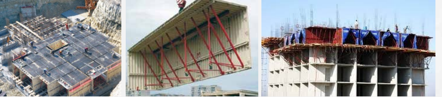
Şekil 4.3. Tünel kalıp sistem ile bina inşaatı
