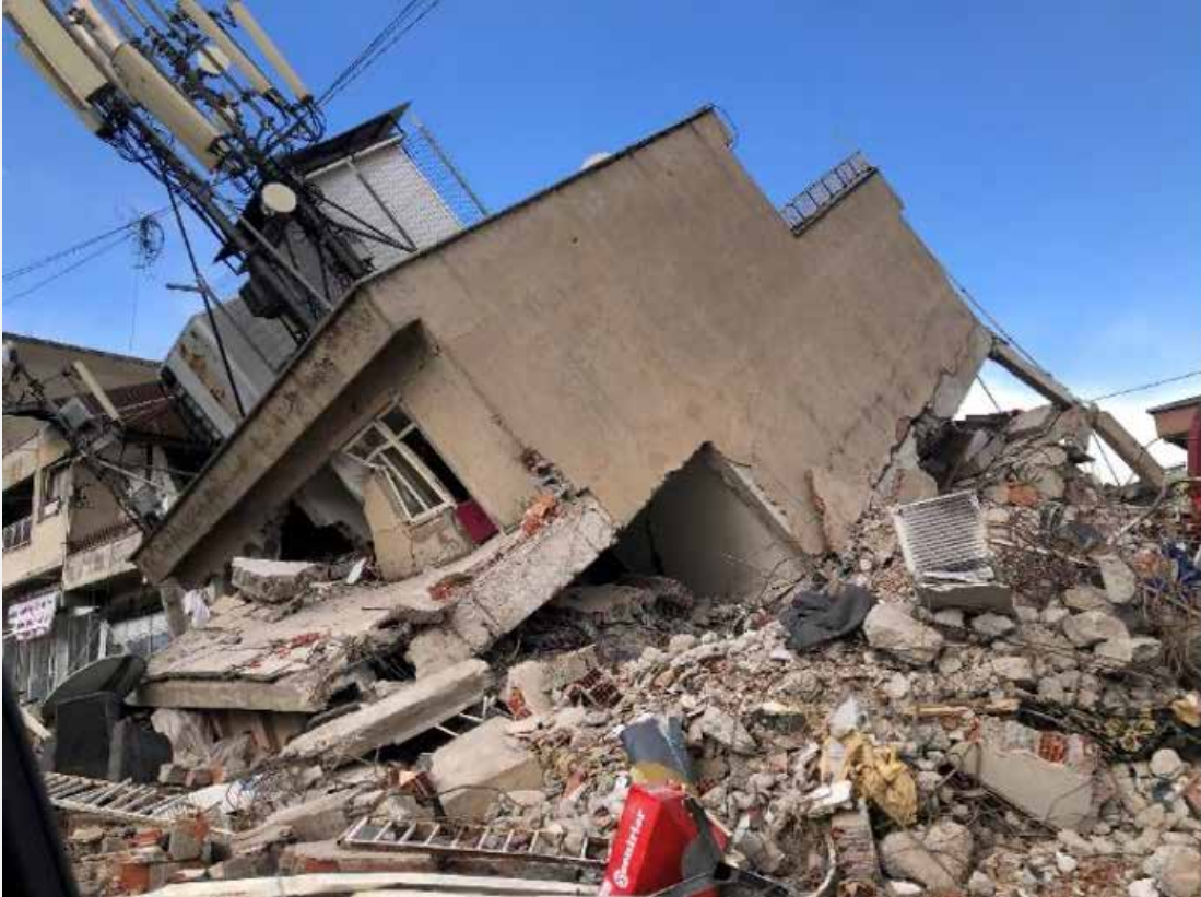
Şekil 3.81. Yıkılan bir binada bulunan baz istasyonundan görünüm
