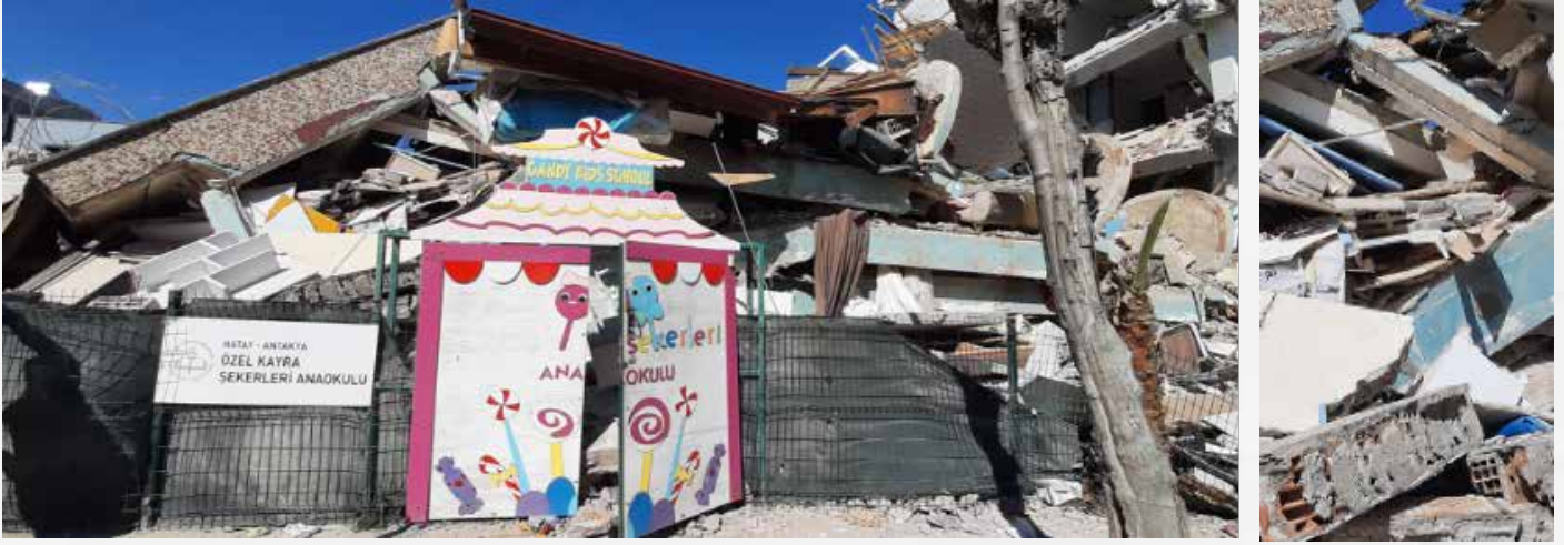
Şekil 3. Kayra Şekerleri Anaokulu, Antakya
