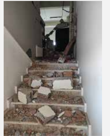
Şekil 3.50. Asma tavan ve bölme duvar hasarları
