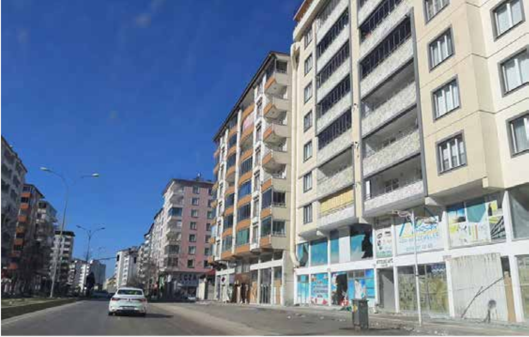
Resim 10. Pazarlık İlçesi D360 karayolu üzerinde bulunan 8-10 katlı betonarme binalar
