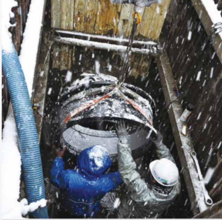
Şekil 5.2.6. Büyük Doğu Japonya Depremi sonrasında 800 mm çaplı bir su dağıtım borusunun tamiri (Wakamatsu ve diğ., 2016).
