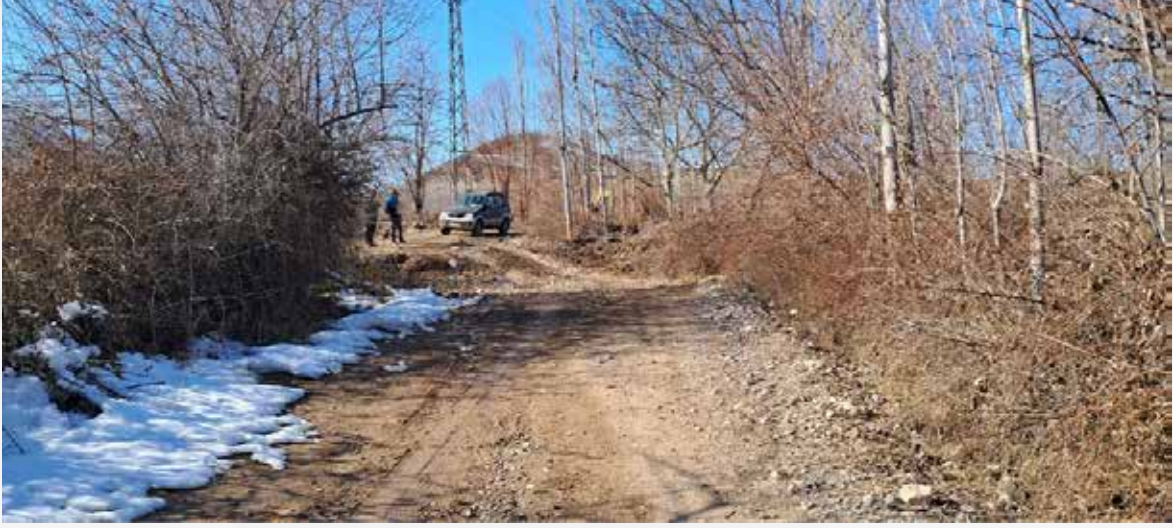
Şekil 1.20. Küçükören batısında ~5 m yol ötelenmesi (Enlem: 37° 38' 22,938" N; Boylam: 37° 25' 45,936" E; Yükseklik: 898 m.)
