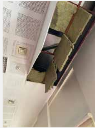
Şekil 3.50. Asma tavan ve bölme duvar hasarları
