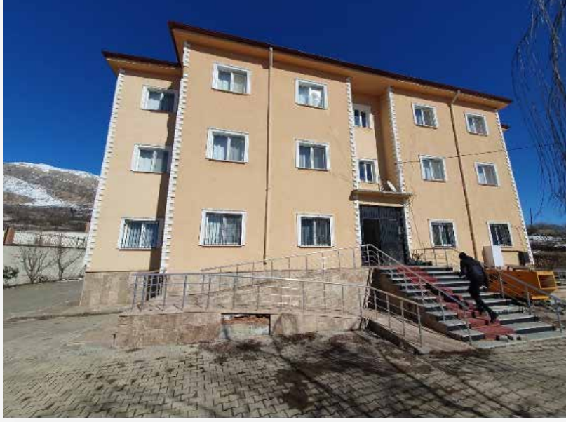
Şekil 3.66. Tut İlçesi Devlet Hastanesi Lojmanı
