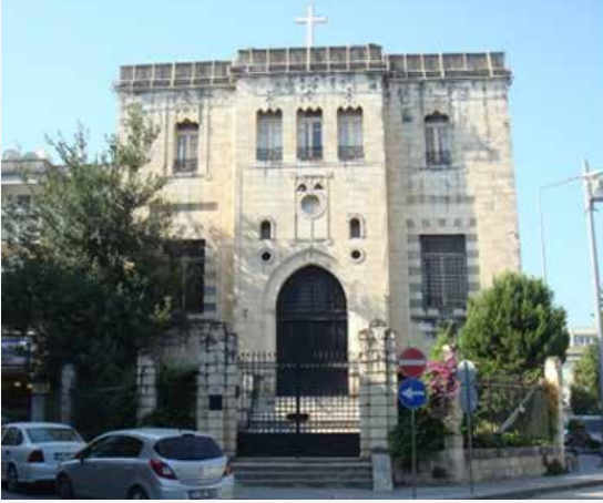
a) Depremden önceki durumu
