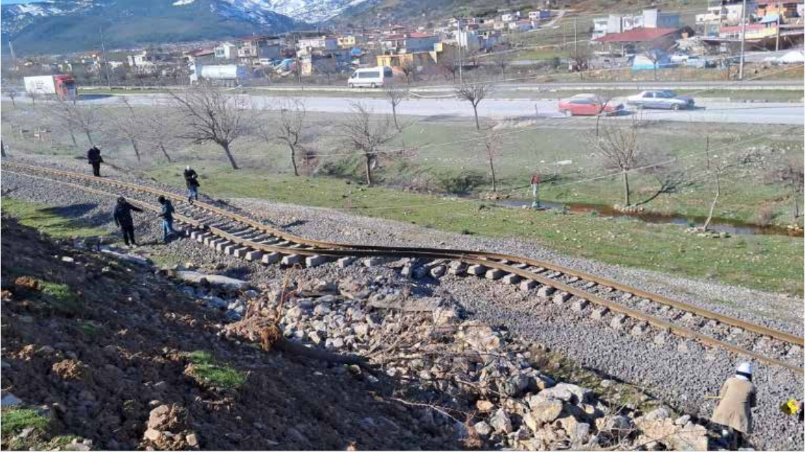
Şekil 1.13. Şekeroba doğusunda tren raylarında meydana gelen sol yanal ötelenme (Enlem: 37° 16' 13,62" N; Boylam: 36° 47' 0,678" E; Yükseklik: 540 m)
