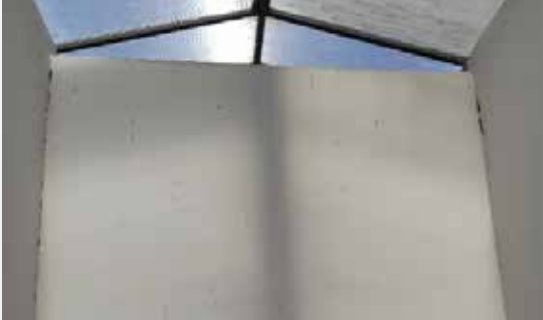
Şekil 3.56. Kalkan duvar düşme tehlikesi ve asma tavan hasarı
