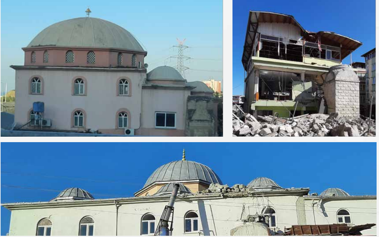
Şekil 35. Hatay'da hasar görmüş ve minareleri göçmüş bazı camiler
