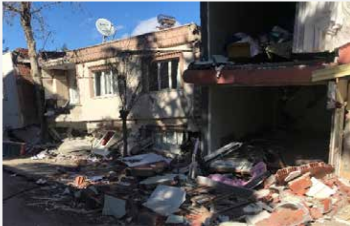
Resim 18. Depremden önce 3 katlı olan binanın deprem sonrası görünümü.
