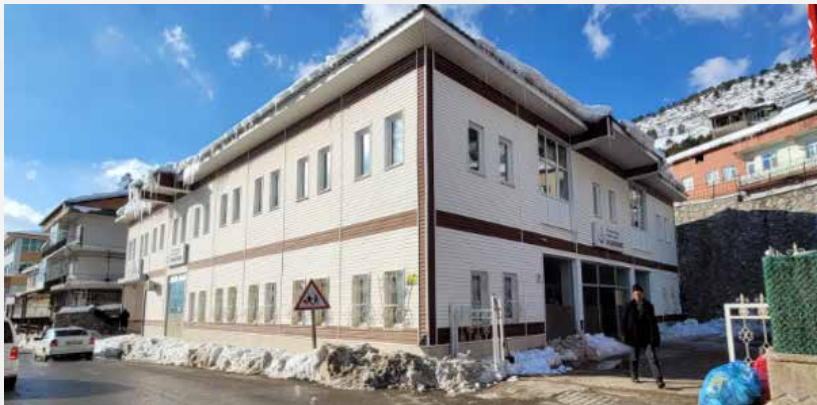
Şekil 3.65. Çelikhan İlçesi ASM binası
