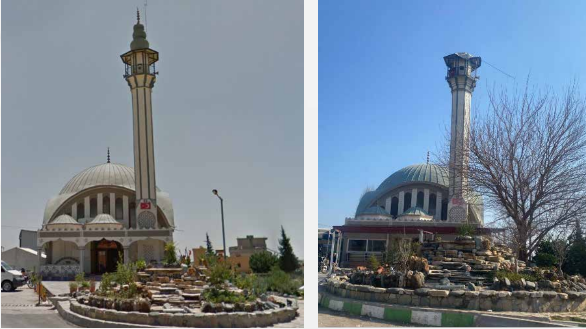
a) Depremden önceki durumu
