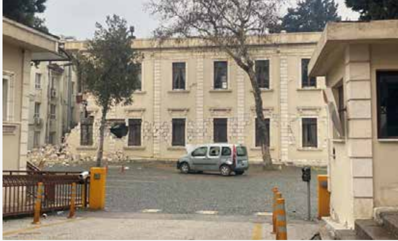
Şekil 26. Hatay Valilik Binası
