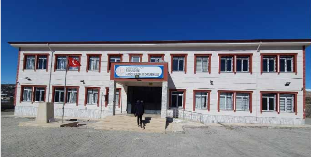
Şekil 3.67. Boyundere Hatice Yıldırım Ortaokul binası
