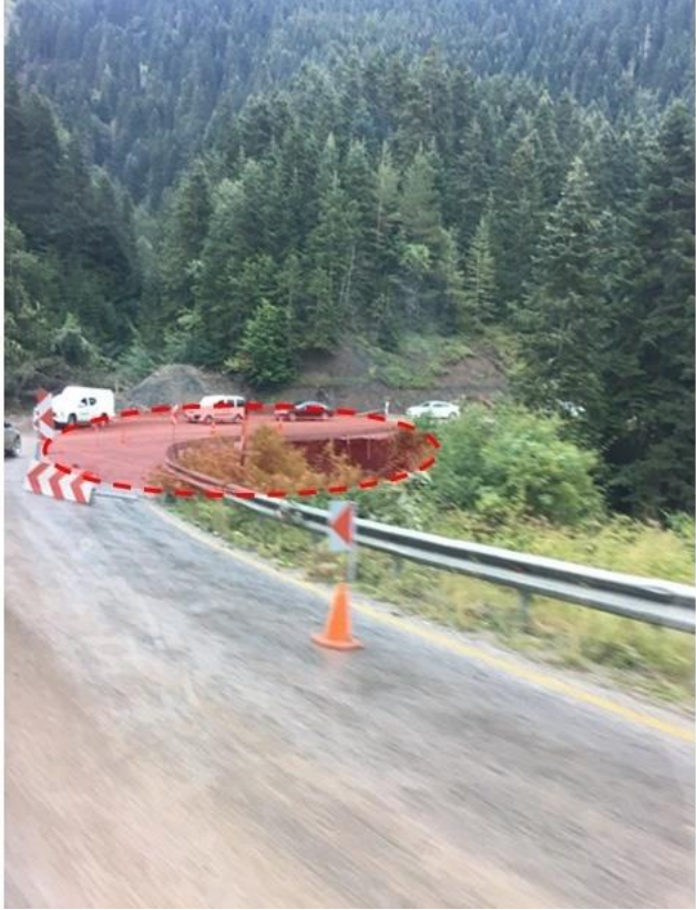
Şekil 3: Yol sağındaki göçmeler
