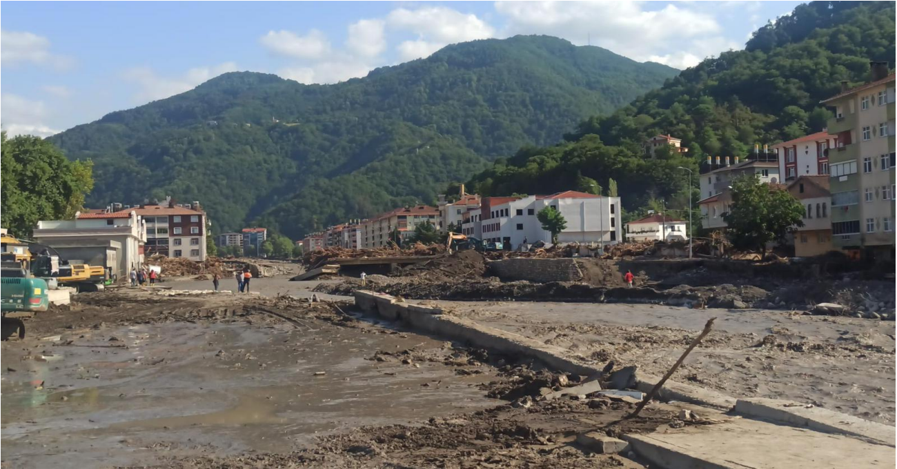
Şekil 11: Yıkılan köprü ve sol sahil duvarları
