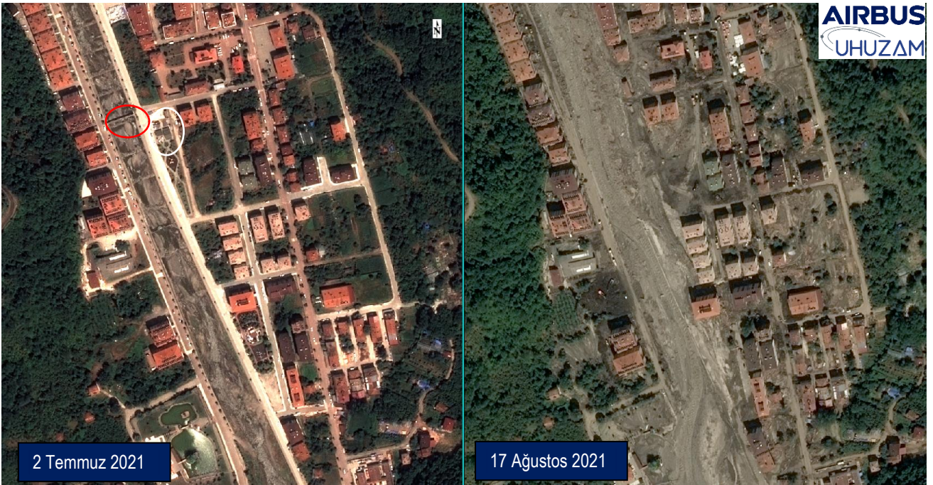
Şekil 19: Ezine çayı ve Bozkurt şehir merkezi
