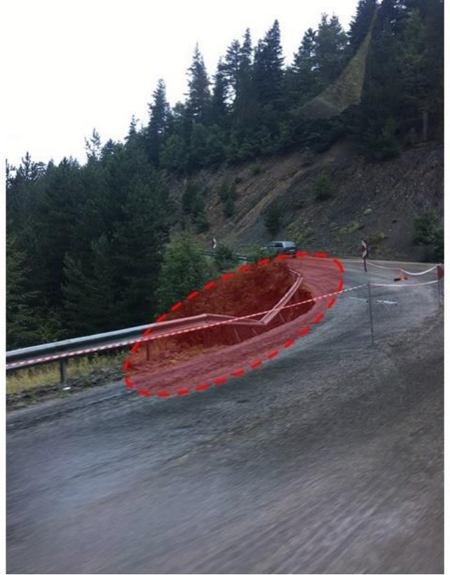
Şekil 3: Yol sağındaki göçmeler
